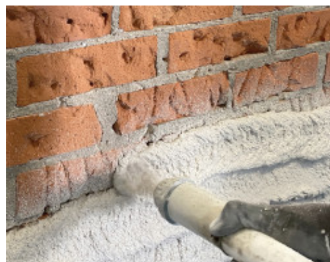
Applicazione di Mape-Antique NHL ECO Risana con intonacatrice
