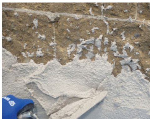
Applicazione di Mape-Antique NHL ECO Risana a cazzuola su supporto in tufo
