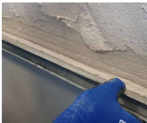
Livellamento di Mape-Antique NHL ECO Risana con staggia
