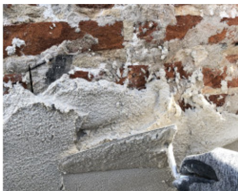
Applicazione di Mape-Antique NHL ECO Risana a cazzuola su supporto in mattone
