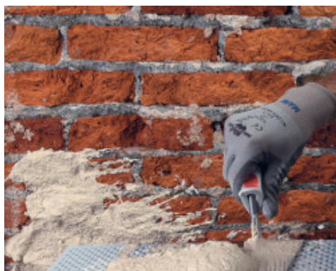
Applicazione di Mape-Antique NHL Eco Rinzafo su supporto in mattone pieno
