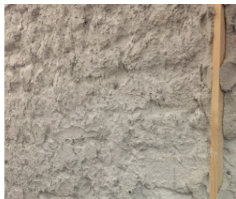
Applicazione a "poro chiuso" di Mape-Antique NHL Eco Rinzafo
