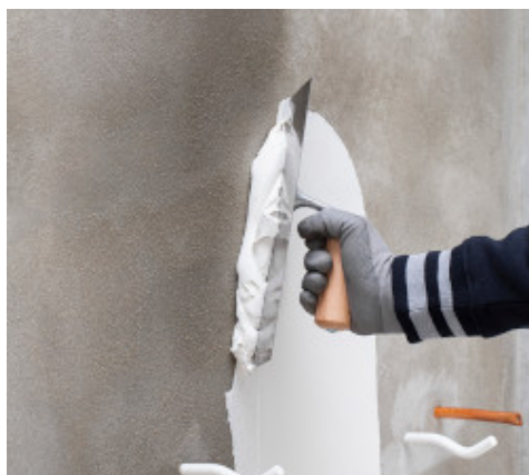
Applicazione di Planitop Superfine
