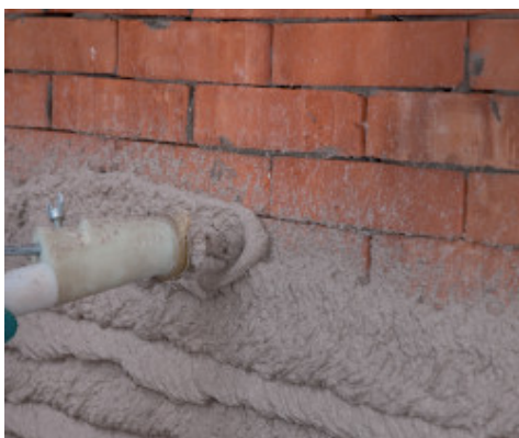
Applicazione a spruzzo di Planitop HDM Restauro su parete
