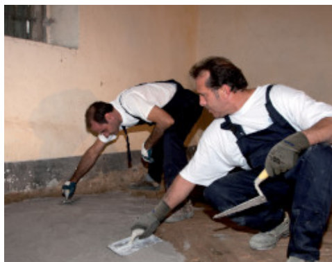
Posa del primo strato a spatola di Planitop HDM Restauro all'estradosso di una volta
