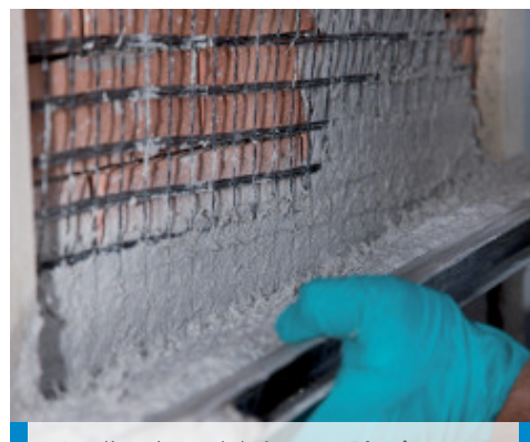
Applicazione del sistema Planitop HDM Restauro e Mapegrid G 220 su parete in muratura
