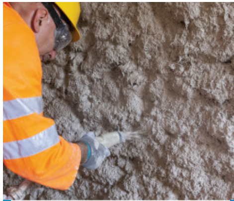
Seconda mano di Planitop Intonaco Armato
