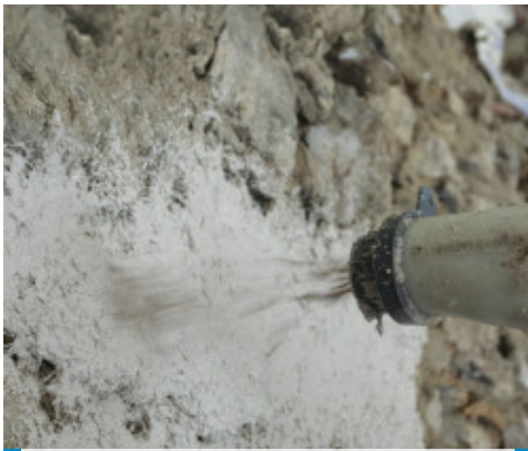
Prima mano di Planitop Intonaco Armato
