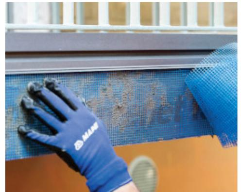
*Rasatura mediante Planitop 200 armato con Mapenet 150*
