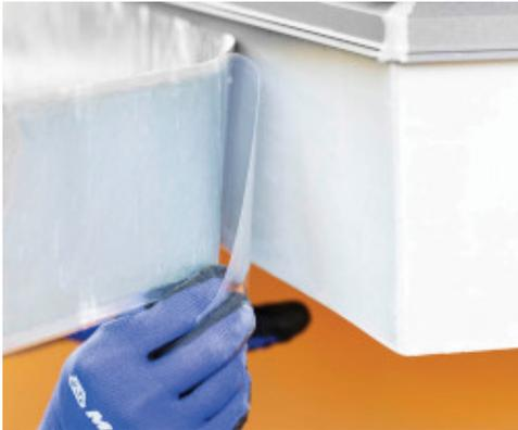
*Rimozione del film di protezione e applicazione della lamina*
