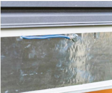
*Collegamento della lamina alle armature mediante filo elettrico*
