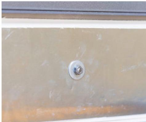
*Collegamento della lamina alle armature mediante barra filettata*
