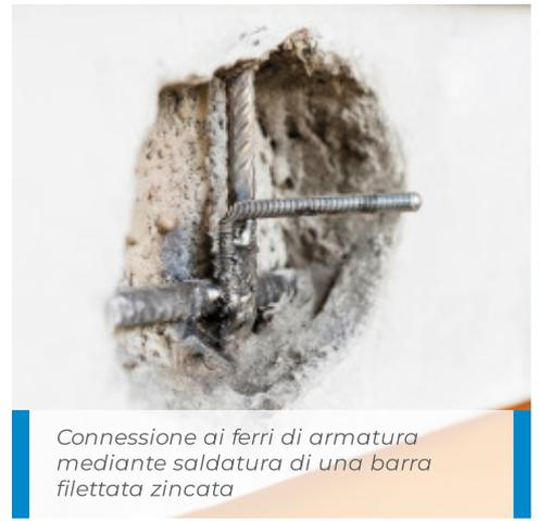
*Connessione ai ferri di armatura mediante saldatura di una barra filettata zincata*
