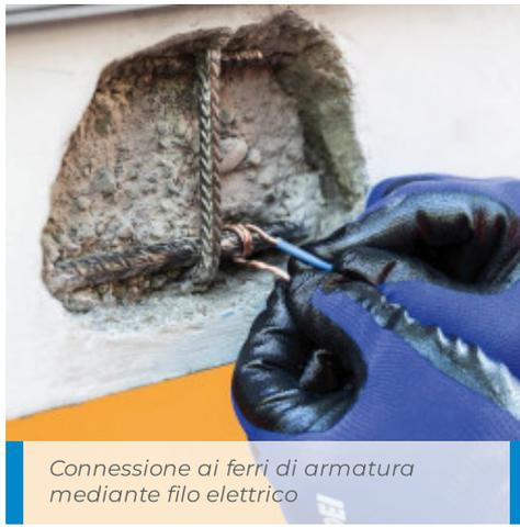
*Connessione ai ferri di armatura mediante filo elettrico*
