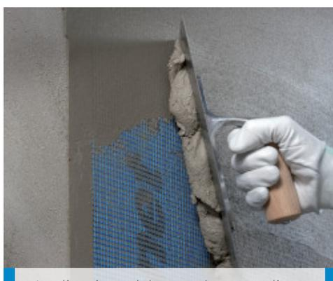
Applicazione del secondo strato di Planitop 200 con interposta Mapenet 150 su supporti di natura differente
