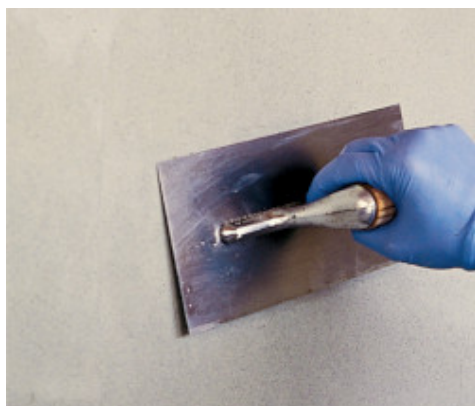
Lisciatura della superficie di Planitop 560 con spatola metallica
