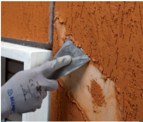
Rimozione del rivestimento plastico non aderente
