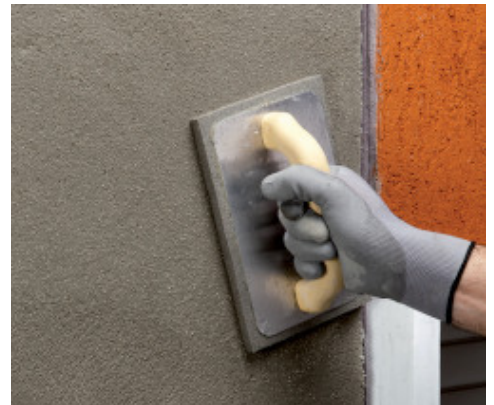
Frattazzatura di Planitop 217
