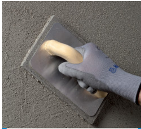
Frattazzatura di Planitop 517
