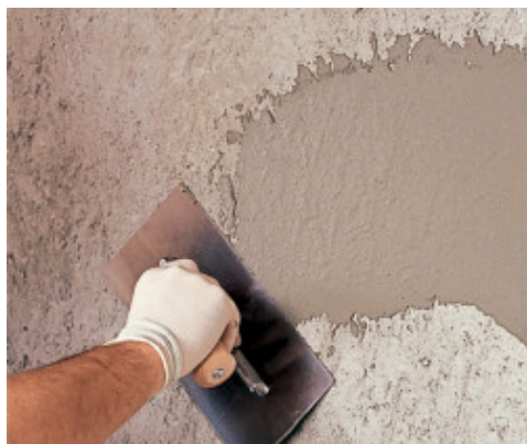
Applicazione di Planitop 540 con spatola metallica
