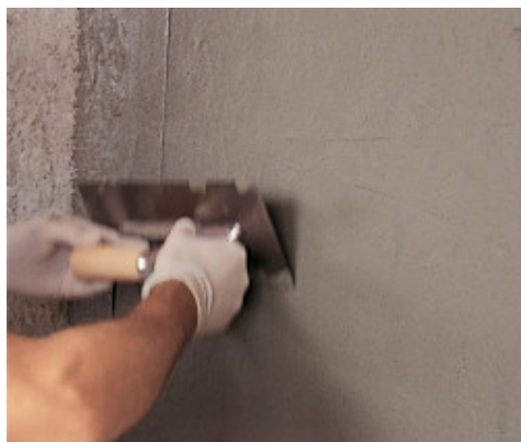
Applicazione di Planitop 540 con spatola metallica
