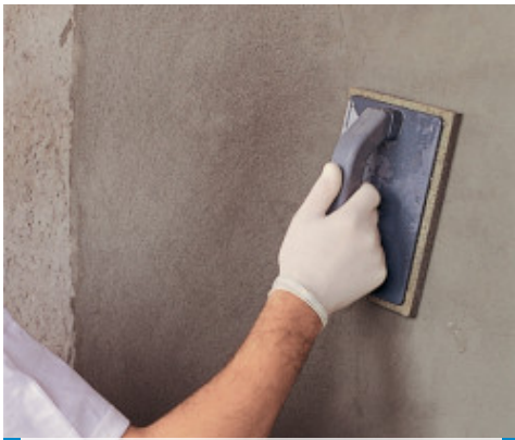
Finitura della superficie di Planitop 540 con frattazzino di spugna
