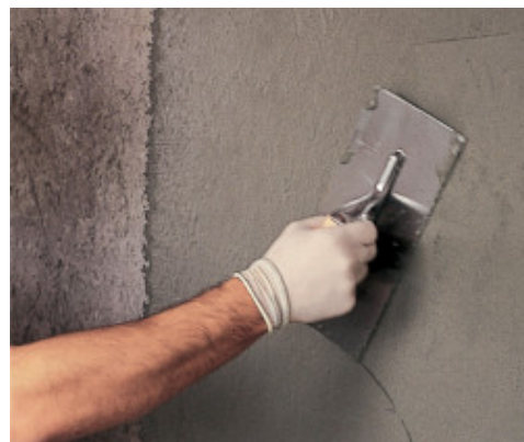
Lisciatura della superficie di Planitop 540 con una spatola metallica
