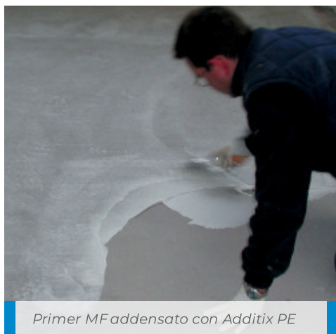
Stuccatura di un giunto con Primer MF additivato con Additix PE
