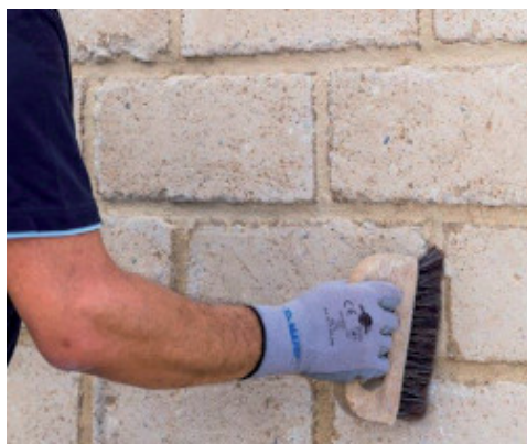
Preparazione del supporto prima dell'applicazione del prodotto
