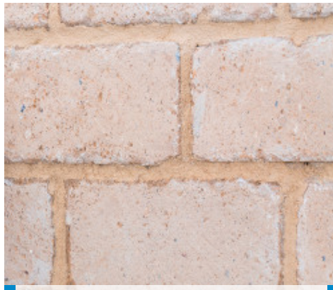
Supporto dopo l'applicazione del consolidante
