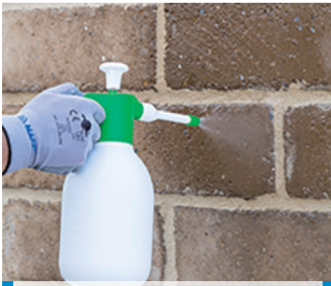
Applicazione a spruzzo con irroratore di tipo manuale a bassa pressione
