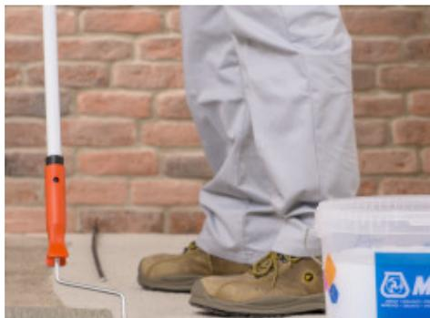
Stesura di Primer 3296 come preparazione del supporto nel rinforzo di solai in latero cemento con Planitop HPC Floor
