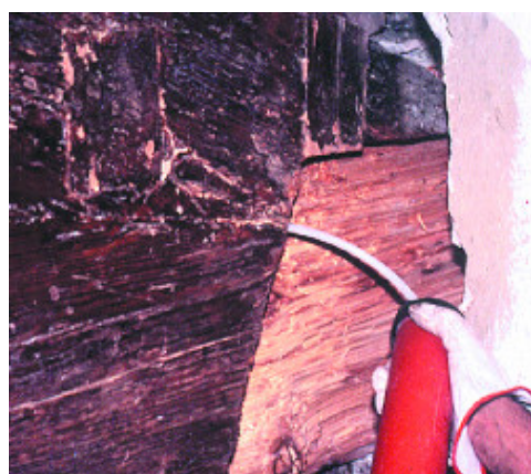
Iniezione di Mapewood Gel 120
