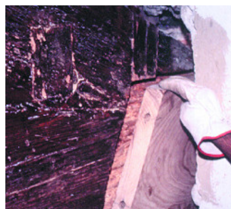
Riprofilatura della trave
