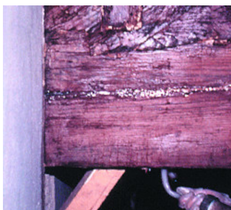
Iniezione di Mapewood Gel 120
