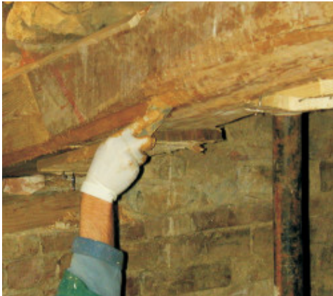
Applicazione di Mapewood Paste 140
