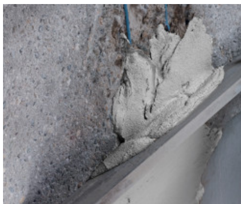
Staggiatura di Planitop Rasa & Ripara Zero
