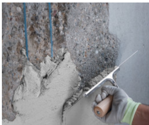
Applicazione a spatola di Planitop Rasa & Ripara Zero
