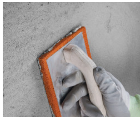
Frattazzatura di Planitop Rasa & Ripara Zero
