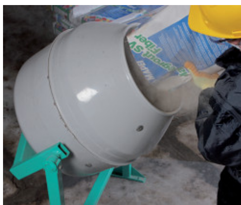
Preparazione dell'impasto di MapegrouT SV Fiber
