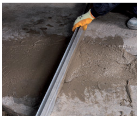
Staggiatura di MapegrouT SV Fiber
