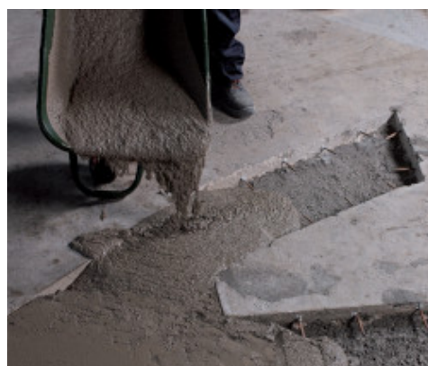
Applicazione di MapegrouT SV Fiber nella zona da ripristinare
