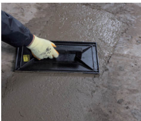
Frattazzatura di MapegrouT SV Fiber
