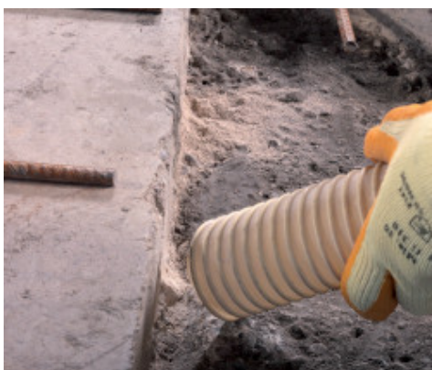
Aspirazione della polvere
