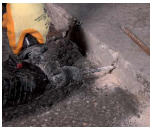
Preparazione dei fori per l'inserimento dei ferri (spinottatura)
