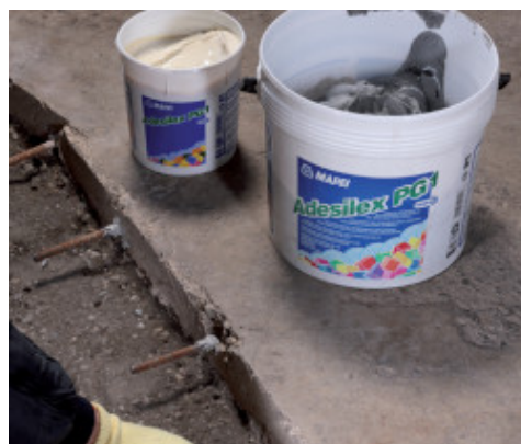
Fissaggio dei ferri per la spinottatura con Adesilex PG
