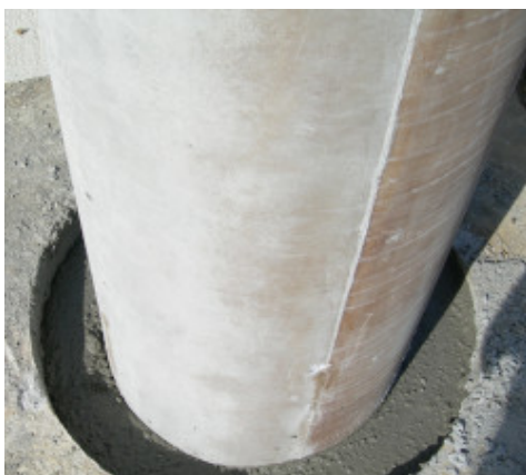
Inghisaggio di pilastro prefabbricato
