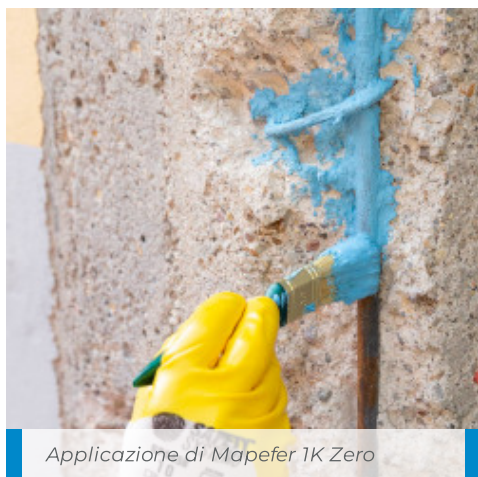
Applicazione di Mapefer 1K Zero sui ferri di armatura di un viadotto
