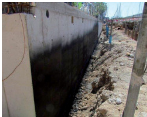
Muro di fondazione impermeabilizzato con Plastimul 2K Reactive
