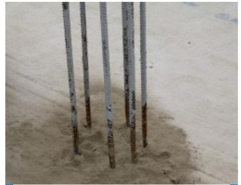
Applicazione di Mapeproof Seal prima della stesura dello spezzone di telo bentonitico Mapeproof
