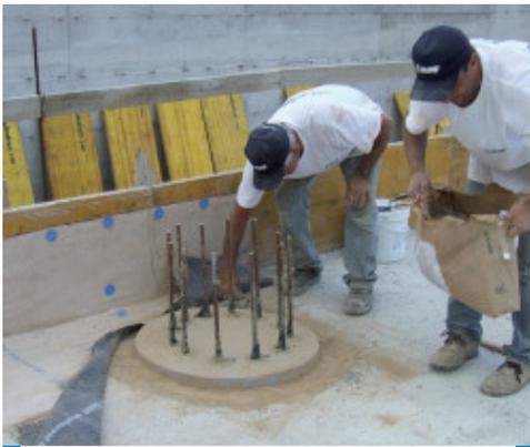
Applicazione di Mapeproof Seal attorno alle teste di palo
