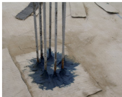
Fig. 3 - Sigillatura con Mapeproof Mastic di spezzone di telo Mapeproof ai ferri d'armatura
