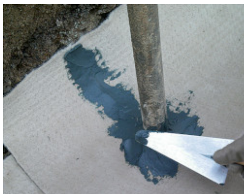
Fig. 1 - Applicazione di Mapeproof Mastic con cazzuola attorno a tubazione passante
