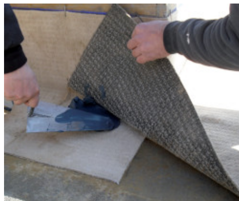
Fig. 6 - Sigillatura con Mapeproof Mastic tra teli bentonitici Mapeproof
