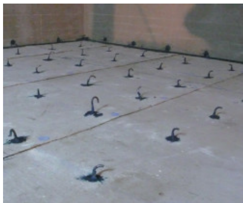
Fig. 4 - Stuccatura di connettori con Mapeproof Mastic
