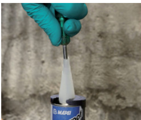
Foratura della membrana di protezione di Mapeproof Swell
