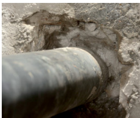
Demolizione della struttura intorno al tubo
