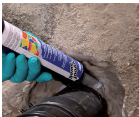
Applicazione di Mapeproof Swell intorno al tubo
