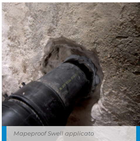
Demolizione della struttura intorno al tubo
