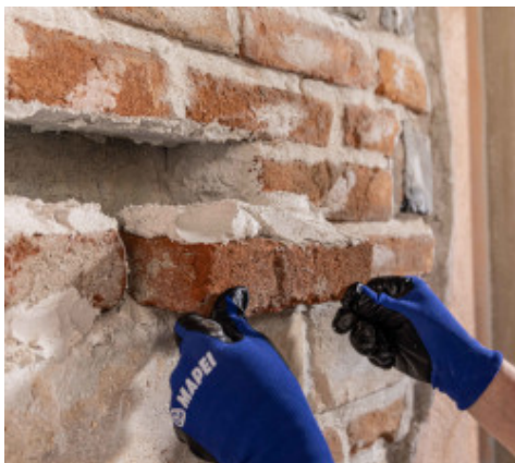
Ricostruzione di muratura in mattoni
