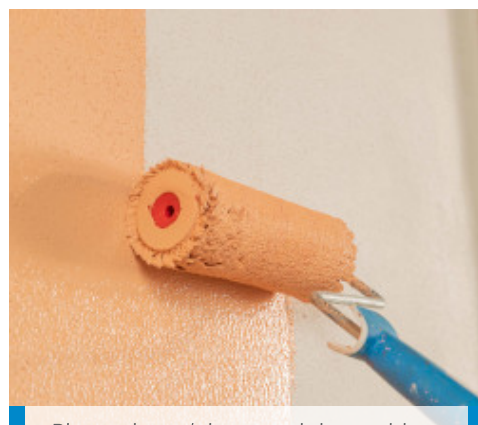
Pittura dei supporti ricostruiti con Mape-Antique NHL Eco Restaura
