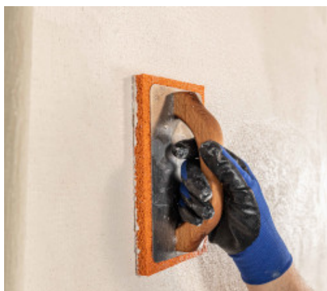
Finitura con frattazzino di spugna
