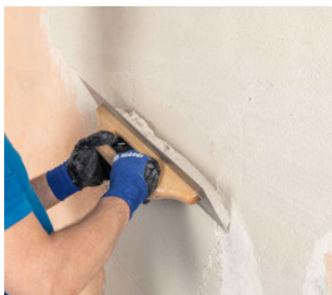
Rasatura di supporti esistenti
