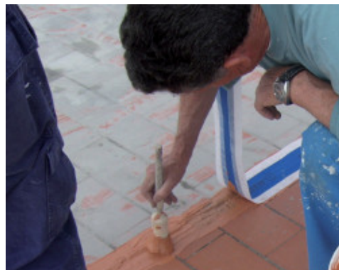
Impermeabilizzazione di un giunto di frazionamento con Mapeband fissato con Aquaflex Roof
