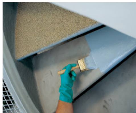
Applicazione di Mapecoat I 24 su calcestruzzo
