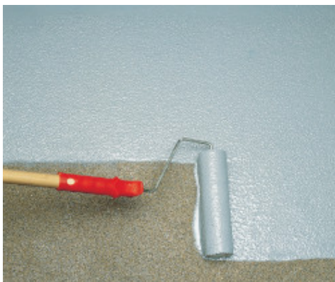
Applicazione di Mapecoat I 24 a rullo
