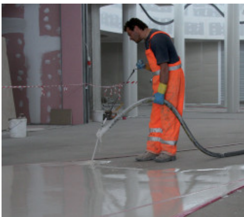
Applicazione a macchina di Ultratop
