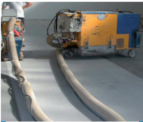
Preparazione del supporto mediante pallinatura
