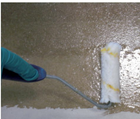
Effetto "Terrazzo alla veneziana" stesura di Mapefloor I 910
