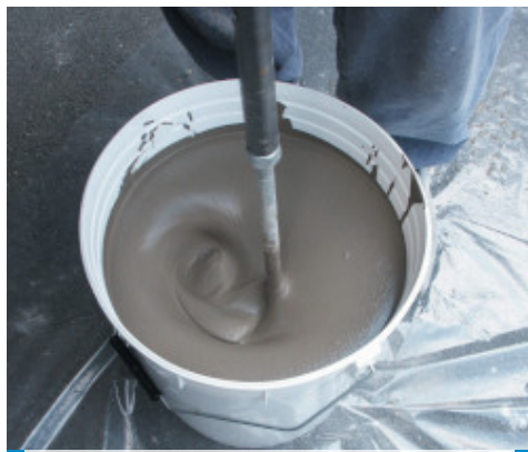
Preparazione del prodotto con trapano
