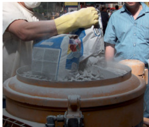
Preparazione di Ultratop a macchina
