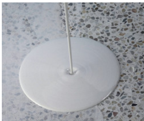
Applicazione di Ultratop Stucco
