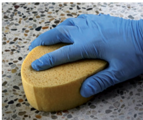
Inumidimento della superficie con una spugna
