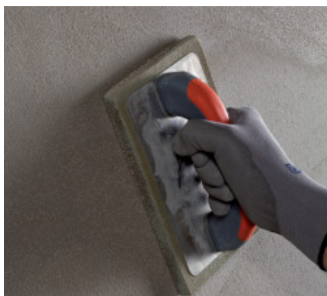
Frattazzatura di Planitop 510
