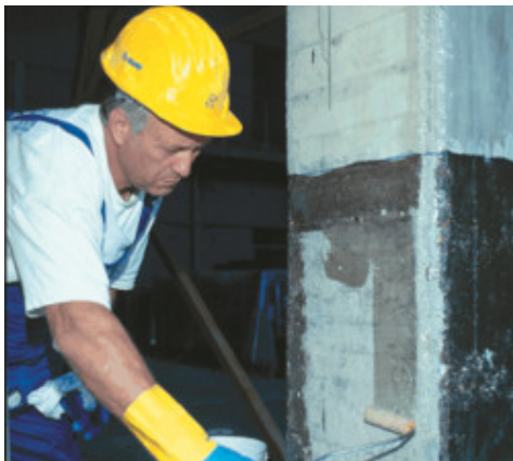
Applicazione di MapeWrap Primer 1
