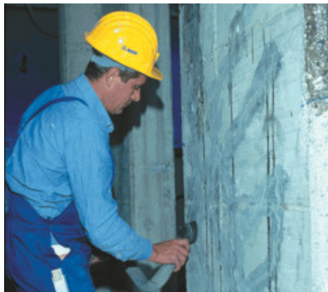
Preparazione del supporto
