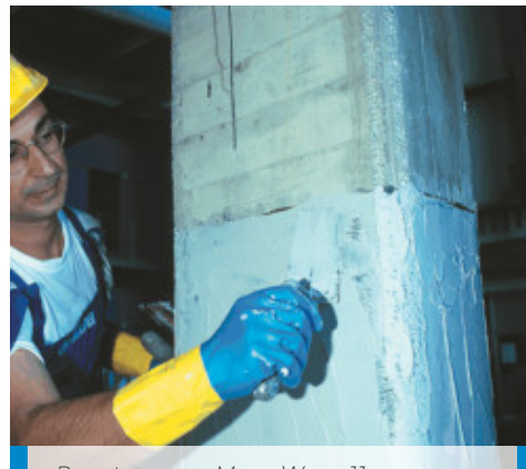
Rasatura con MapeWrap 11 o MapeWrap 12
