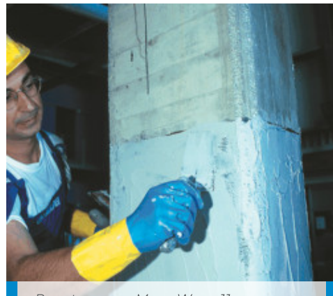
Rasatura con MapeWrap 11 o MapeWrap 12
