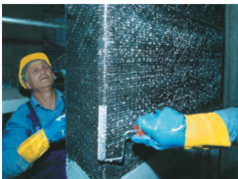
Pressione esercitata sul tessuto con il Rullino per MapeWrap per consentire a MapeWrap 31 di penetrare nel tessuto
