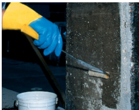
Stesura di MapeWrap 31 sullo strato di MapeWrap 11 (o MapeWrap 12) ancora fresco
