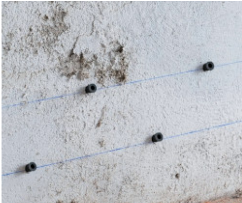
Particolare di iniettori posizionati a quinconce
