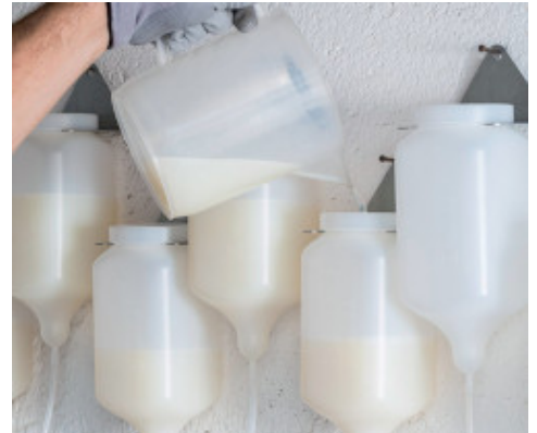
Travasamento della miscela all'interno dei diffusori
