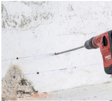
Realizzazione dei fori
