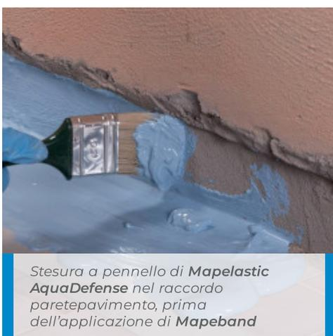
*Stesura a pennello di **Mapelastic AquaDefense** nel raccordo parete-pavimento, prima dell'applicazione di **Mapeband***
