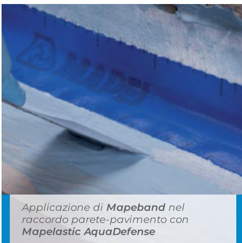
*Applicazione di **Mapeband** nel raccordo parete-pavimento con **Mapelastic AquaDefense***
