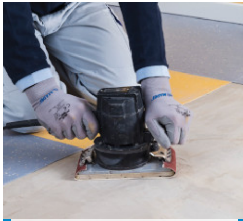
Levigatura dopo 2 ore
