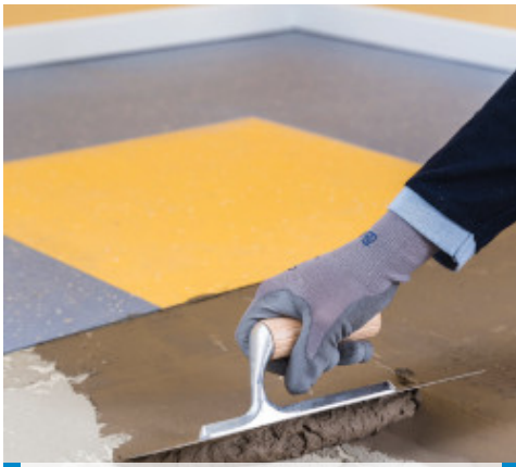
Lisciatura "a zero" del sottofondo
