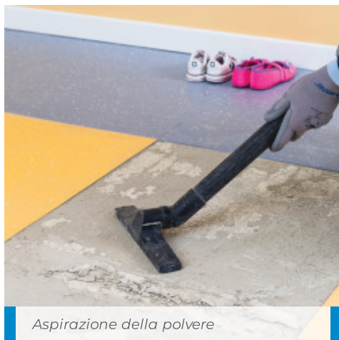
Ripristino localizzato a spessore del sottofondo
