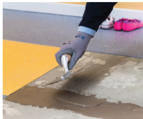
Ripristino localizzato a spessore del sottofondo
