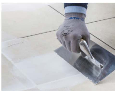
Regolarizzazione e chiusura delle fughe di pavimentazione ceramica esistente con Planiprep 4 LVT
