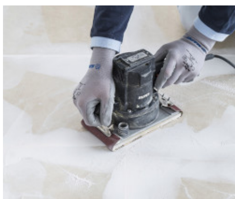
Carteggiatura della superficie regolarizzata con Planiprep 4 LVT
