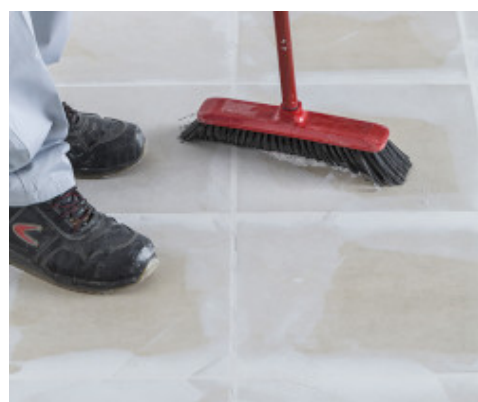
Rimozione della polvere dopo la carteggiatura
