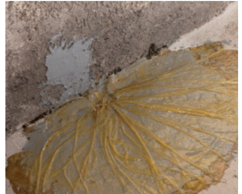
Impregnazione di MapeWrap FIOCCO
