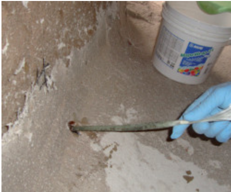
Inserimento di MapeWrap FIOCCO nel foro
