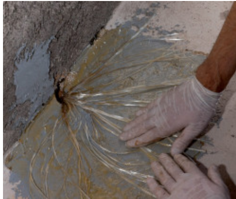
Apertura a ventaglio di MapeWrap FIOCCO
