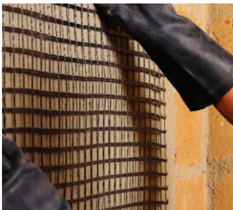
Posizionamento di Mapegrid G 220
