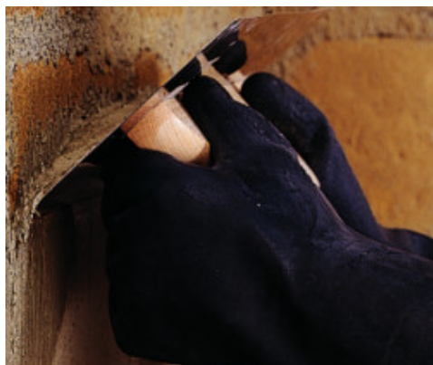
Applicazione del primo strato di Planitop HDM Maxi
