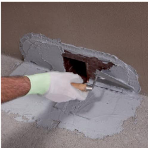
5. Lisciare con una spatola piana e, sul prodotto ancora fresco, effettuare uno spolvero a rifiuto di quarzo sferoidale (con granulometria 0,5), al fine di creare un supporto sufficientemente ruvido per favorire l'adesione del prodotto impermeabilizzante MAPEI che verrà impiegato.
