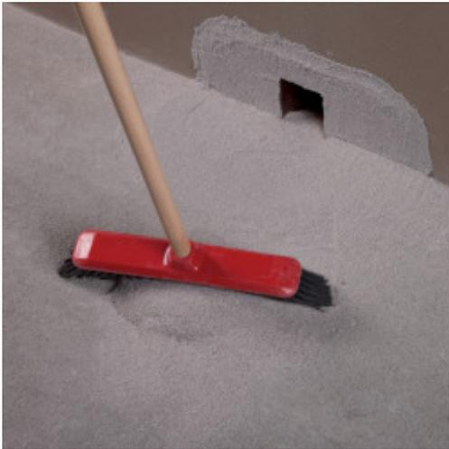
7. Nel raccordo tra orizzontale e verticale applicare un primo strato uniforme del prodotto impermeabilizzante MAPEI scelto, su sottofondo pulito e asciutto.
