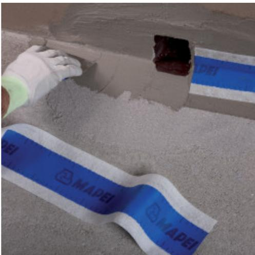
8. Posare **Mapeband** esercitando una leggera pressione sui lati e facendo attenzione a non creare delle grinze e a non inglobare delle bolle d'aria.
