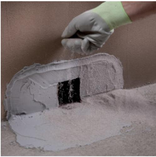
6. Una volta completata la reticolazione di **Adesilex PG4**, rimuovere il quarzo non adesivo.
