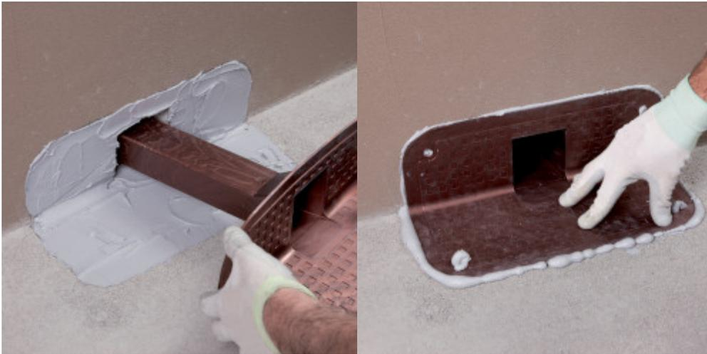
4. Stendere un secondo strato fresco su fresco di **Adesilex PG4**, coprendo completamente **Drain Front**.
