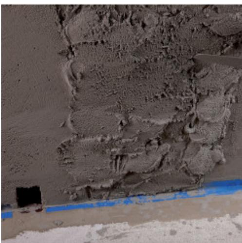
11. Dopo aver applicato il prodotto impermeabilizzante MAPEI secondo le indicazioni contenute nella relativa Scheda Tecnica, incollare la pavimentazione e, infine, stuccare le fughe.
