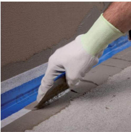
10. Realizzare il nuovo intonaco sul parapetto o ripristinare la parte di intonaco demolita, nel caso di interventi su strutture esistenti.
