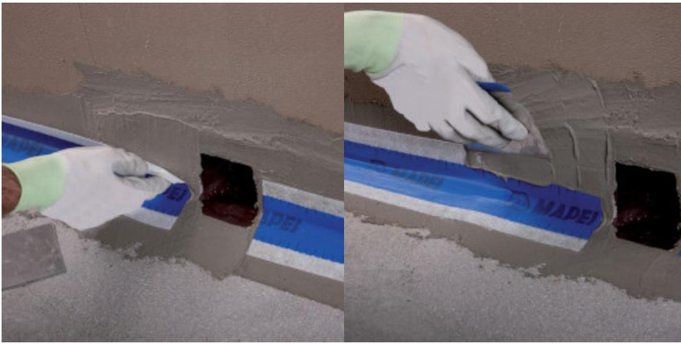
9. Stendere un secondo strato fresco su fresco del prodotto impermeabilizzante MAPEI, coprendo completamente le parti laterali del nastro con il nuovo strato, inglobando i lati della bandella all'interno dei due strati di impermeabilizzante.
