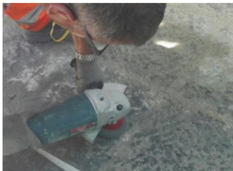
*Abrasione meccanica, operazione preliminare all'applicazione di Mapestone Scraper in caso di eccesso di residui di posa*
