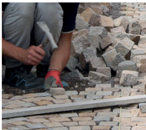
Posizionamento cubetti in porfido
