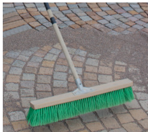
Riempimento fughe con ghiaietto
