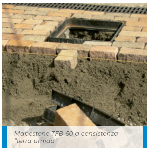
Esempio di posa di cubetti di porfido e lastre di pietra naturale realizzata con il sistema Mapestone
