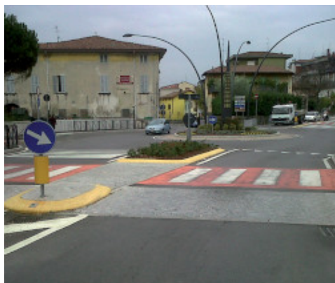
Esempio di dosso stradale su attraversamento pedonale
