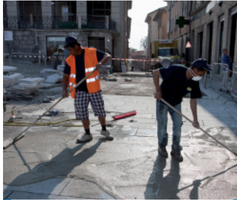
Stesura della boiaccia sulle pietre bagnate
