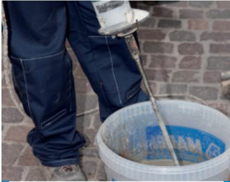
Miscelare Mapestone PFS PCC 2 solo con acqua mediante frusta o betoniera
