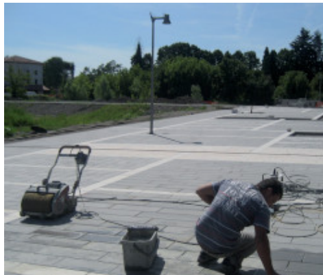
Esempio di pulizia della pavimentazione
