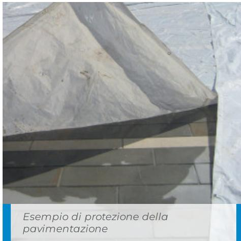
Esempio di protezione della pavimentazione
