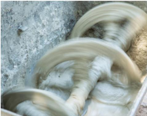
Miscelare **Mapestone PFS 2 Flex** solo con acqua mediante frusta o betoniera
