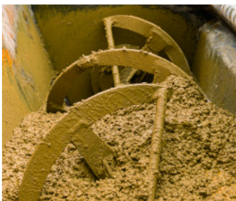
Confezionamento del calcestruzzo con Color Paving Admix
