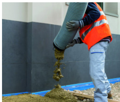
Scarico del calcestruzzo architettonico con Color Paving Admix
