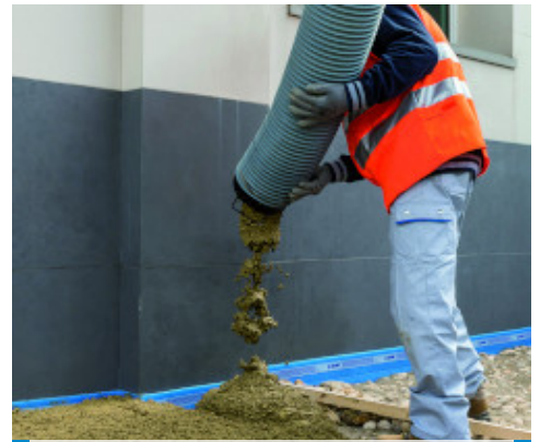
Scarico del calcestruzzo architettonico Color Paving Admix
