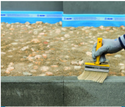
Protezione con Mapewash Protex di tutti i supporti
