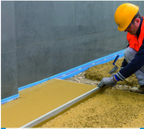
Staggiatura del calcestruzzo
