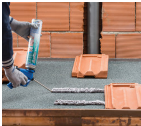
Incollaggio a cordoli di tegole
