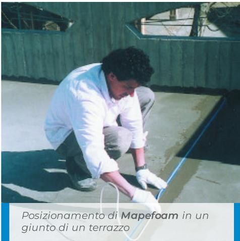
Posizionamento di **Mapefoam** in un giunto di un terrazzo
